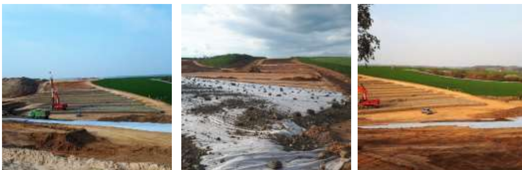
Výstavba dálnice D11
